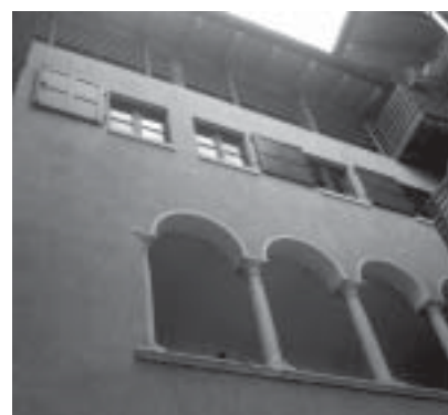
Particolare del cortile interno.
