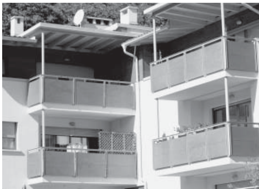
Edificio di recente costruzione dotato di cappotto termico.
