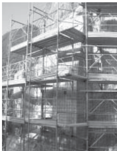
I lavori in via alla Busa.
