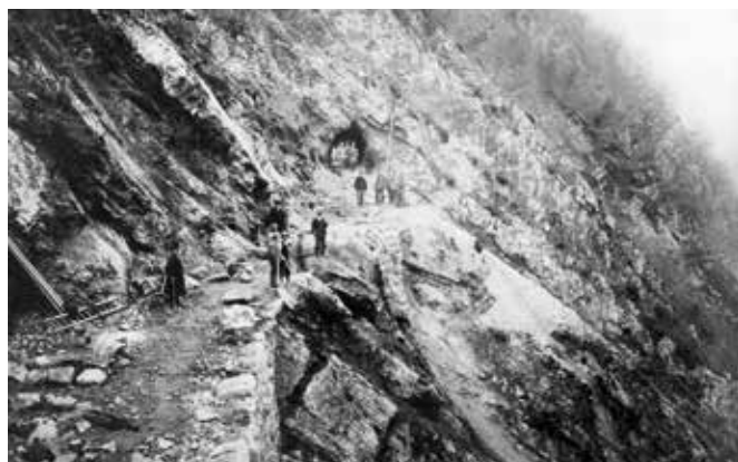
Costruzione strada Cei
