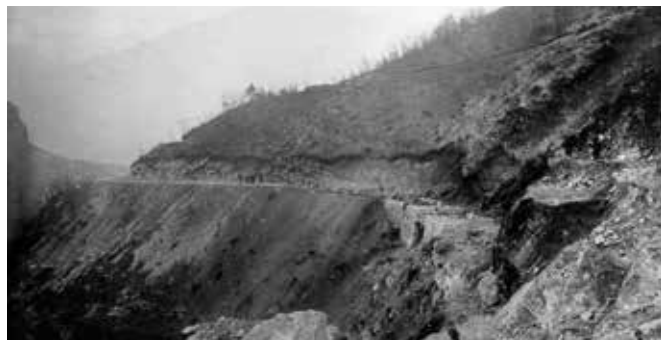
Costruzione strada Cei
