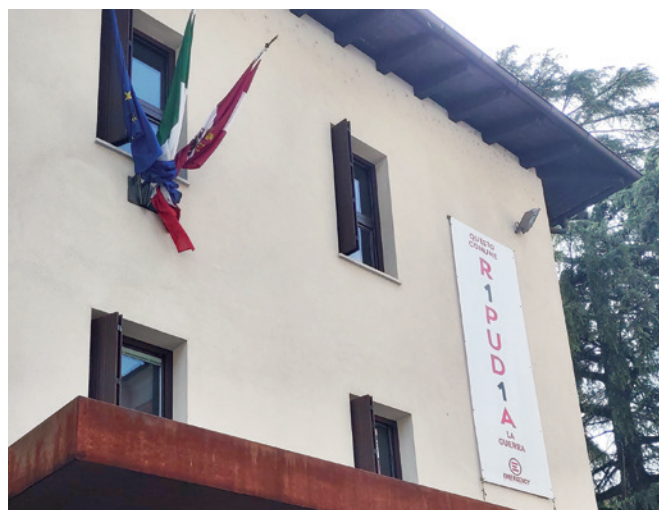
Striscione di adesione sulla facciata del Municipio
