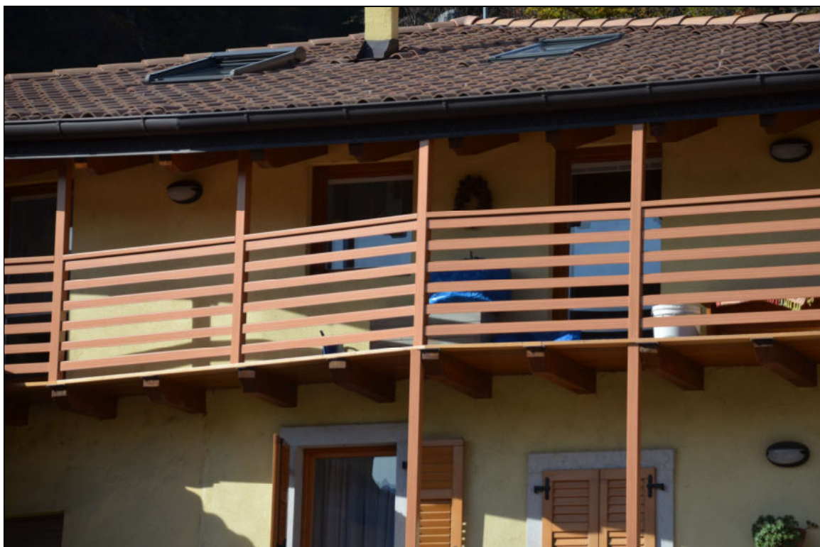
POGGIOLI E BALLATOI CON PARAPETTI IN LEGNO A FILETTI ORIZZONTALI
