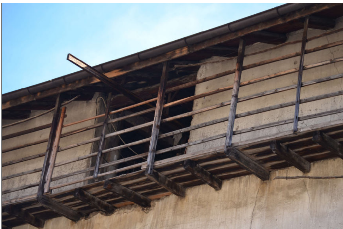
POGGIOLI E BALLATOI CON PARAPETTI IN LEGNO A FILETTI ORIZZONTALI
