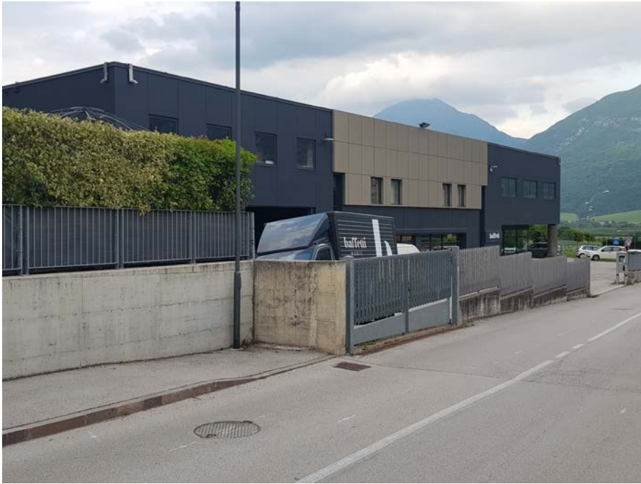
Figura 3: Vista da ovest su Via del Perer verso la sede di Baffetti Mobili. La interruzione del marciapiede nasce dal confine sud della p.ed.690
