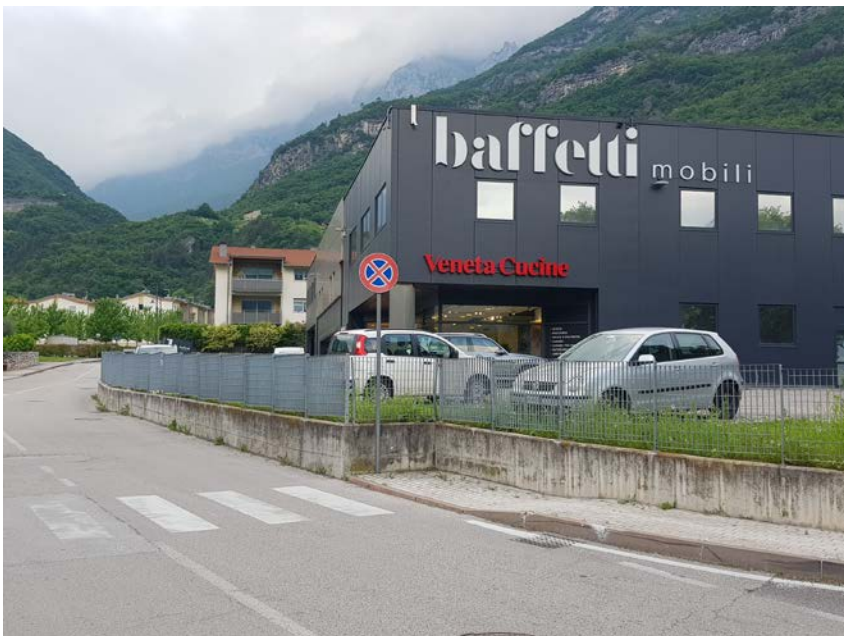
Figura 4: Vista verso ovest in corrispondenza dell'incrocio di Viale Europa e via del Perer. La interruzione del marciapiede corrisponde a tutto il lato sud della p.ed. 690. Si può constatare una considerevole differenza di quota fra la strada e il lotto
