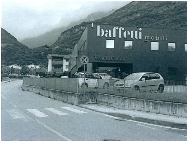
Fig. 1: vista prospettica della proprietà e di alcuni dei parcheggi esterni L'accesso alla proprietà avviene direttamente da via del Perer
