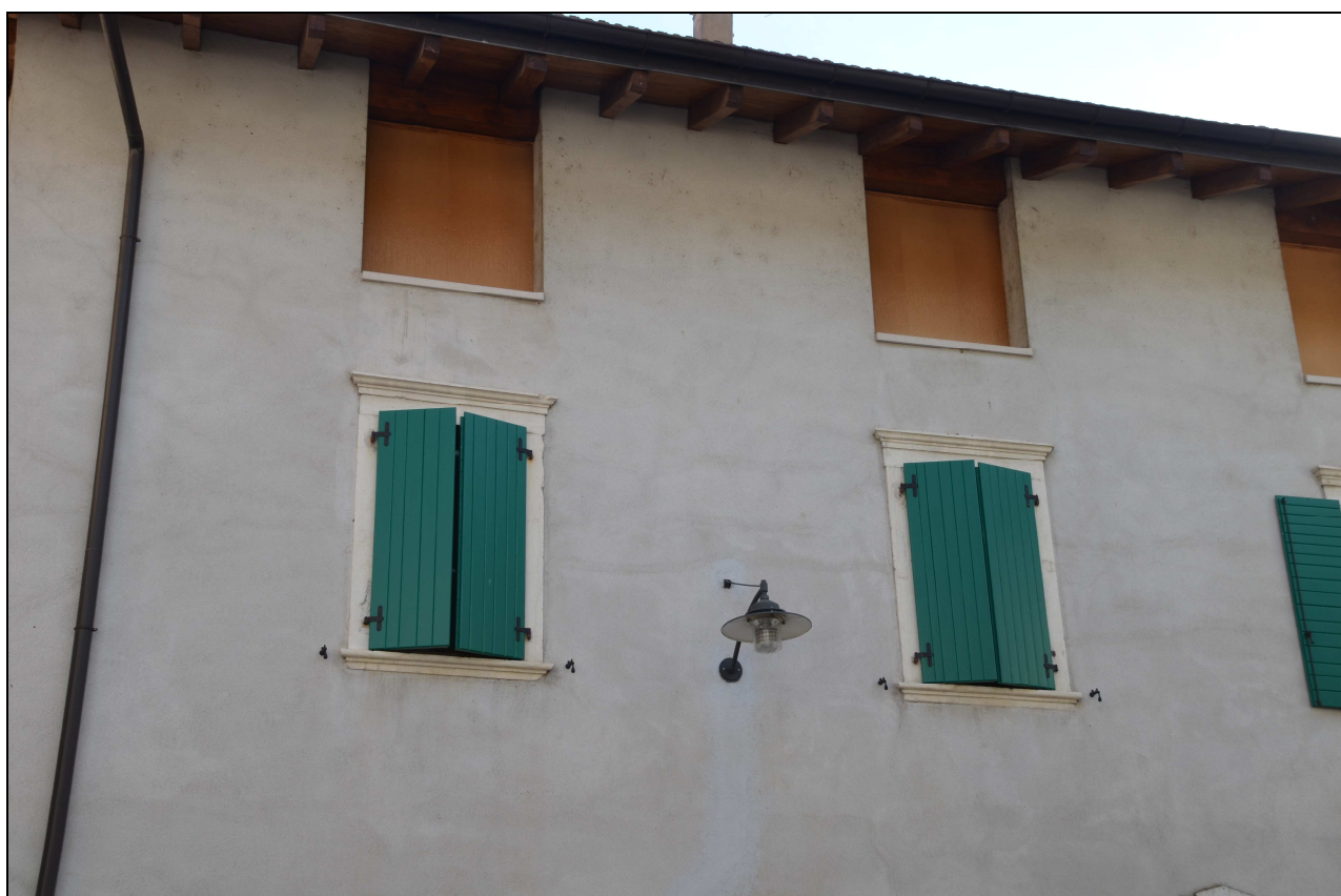
FORI RETTANGOLARI NEL SOTTOTETTO
