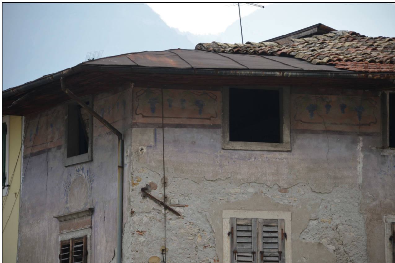
FORI RETTANGOLARI NEL SOTTOTETTO
