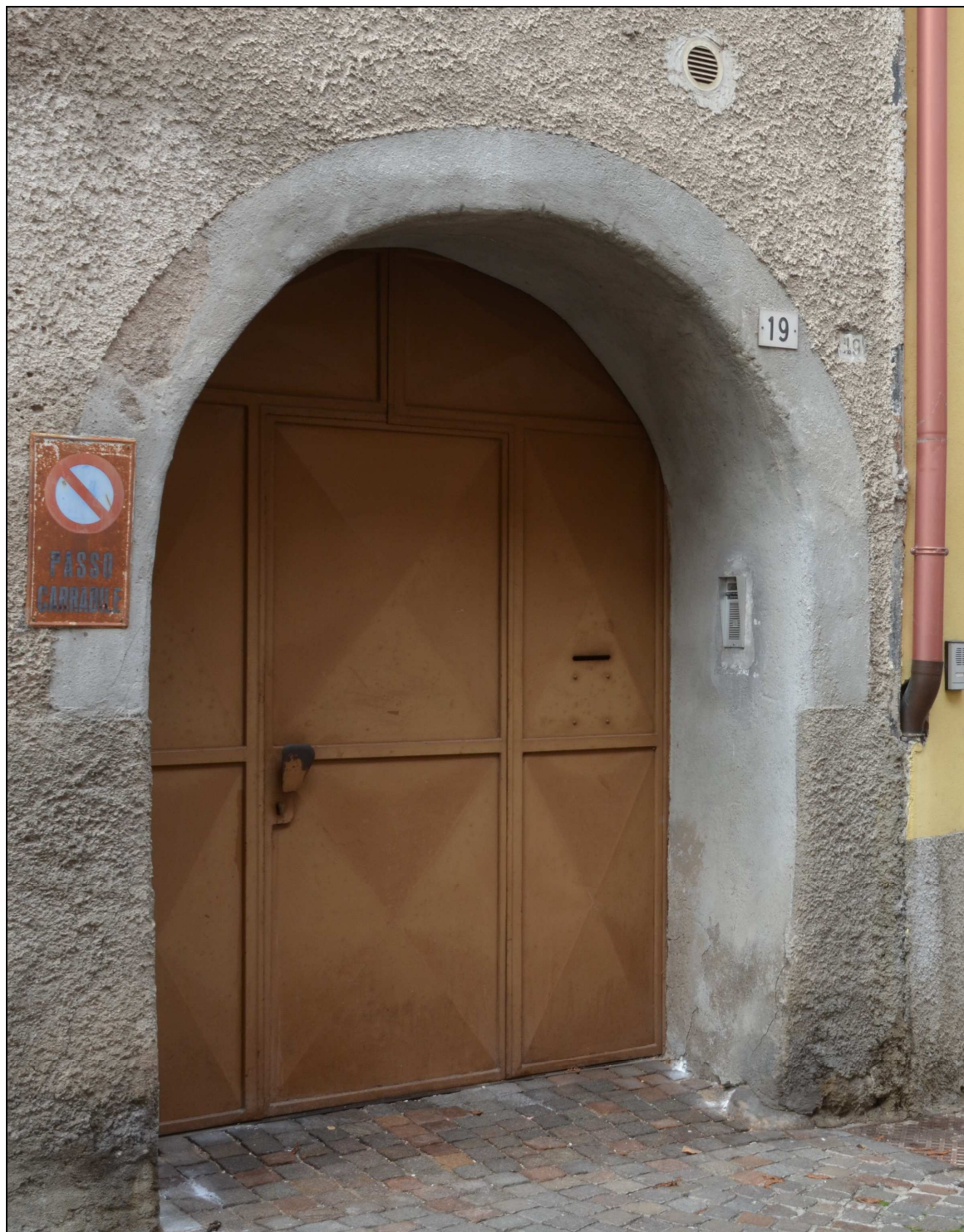
FORMA AD ARCO IN MURATURA
